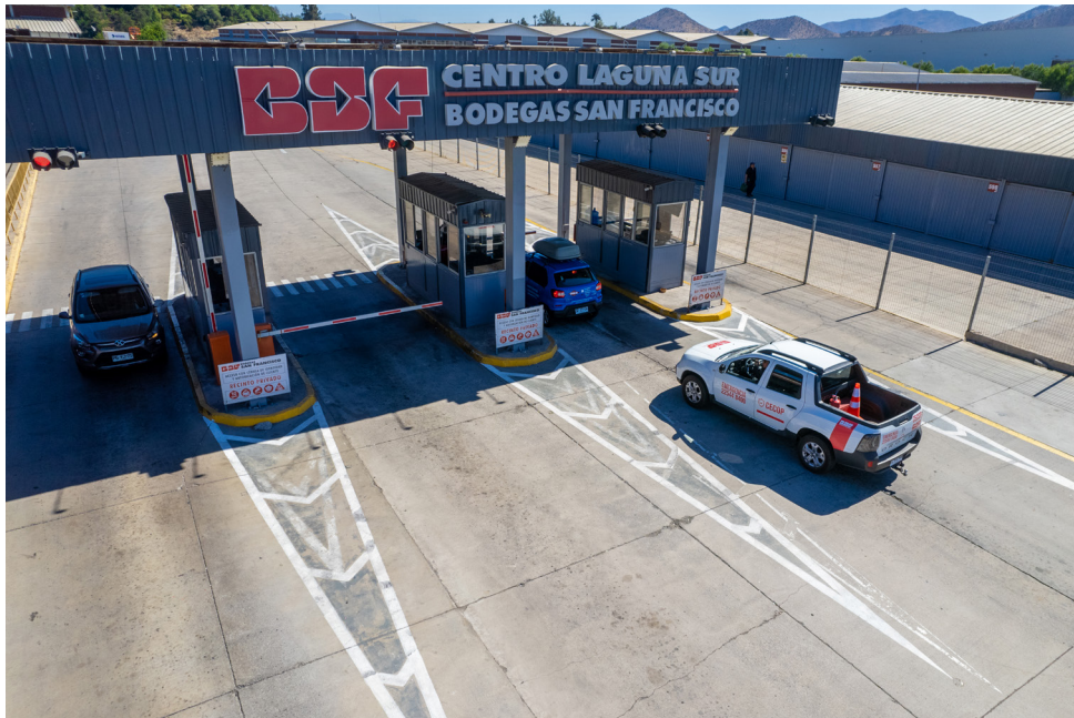
LAGUNA SUR CON 206.000 M2 ubicado en Laguna Sur N° 9600, Pudahuel
